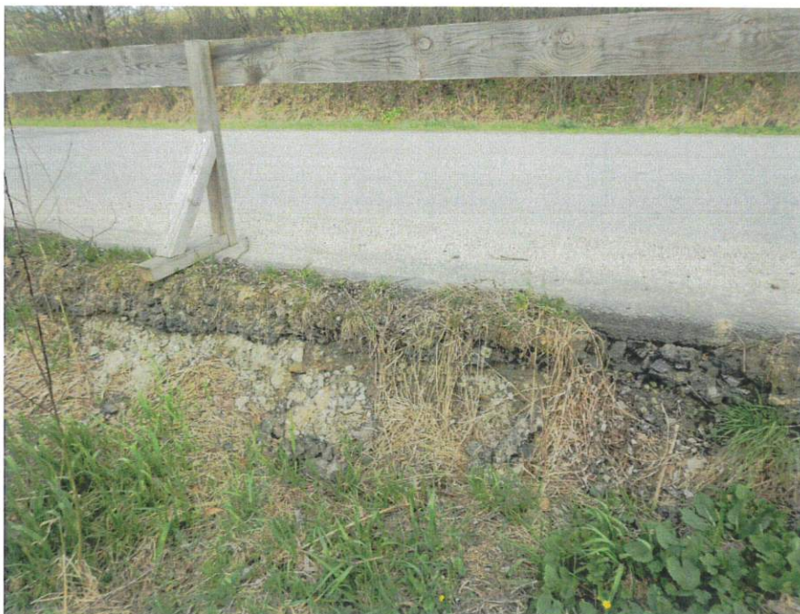
skarpa główna z odsłoniętym nasypem drogowym
